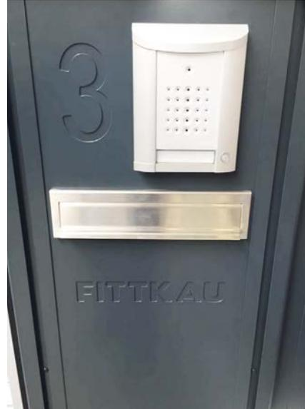
2:: Einwurfklappe aus Edelstahl, Hausnummer und Name gefräst, kombiniert mit Kommunikationssäule
